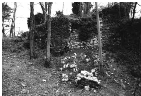
Roccalberti: crollo di un muro medievale addossato ad un più antico muro.
