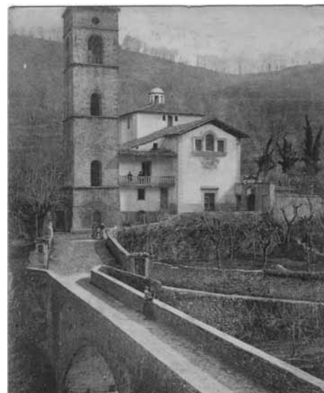
Fig. 1, il ponte di Torrite da un disegno del 1594 (ASMO, confini dello Stato, b. 205 b, fasc. 12), e quello attuale da una immagine dei primi '900 (cartolina di Silvio Fioravanti).
