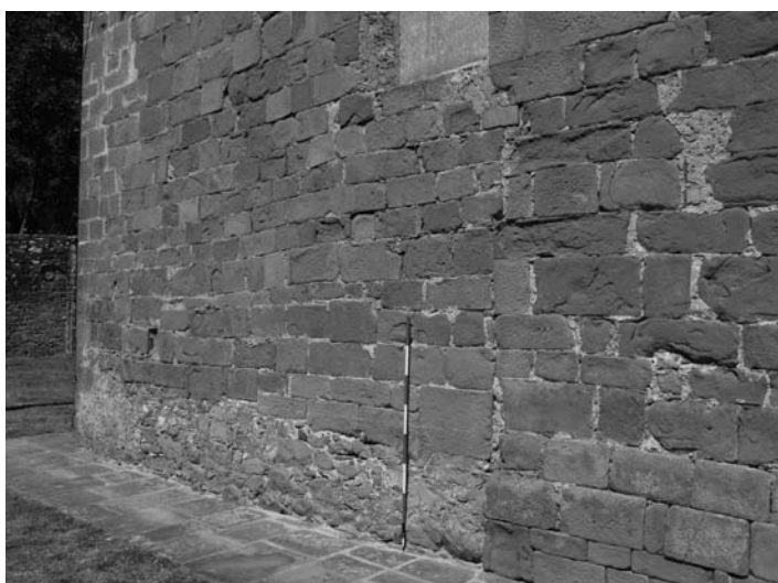
Fianco meridionale della chiesa di S. Maria: sulla destra, lo zoccolo di fondazione con conci ben connessi del primo impianto. A sinistra, il muro aggiunto e di poi, in tempo assai successivo, sottofondato.
